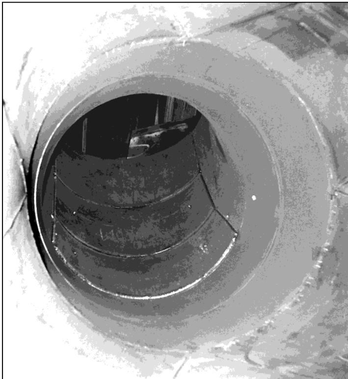
Foto: Blick in den Saugrohrkrümmer auf das Verschleißblech
