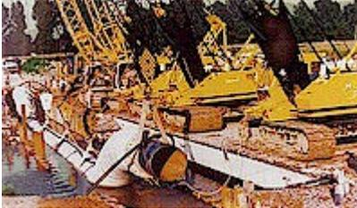
**Abbildung 3 Dükerverlegung durch einen Fluss**
